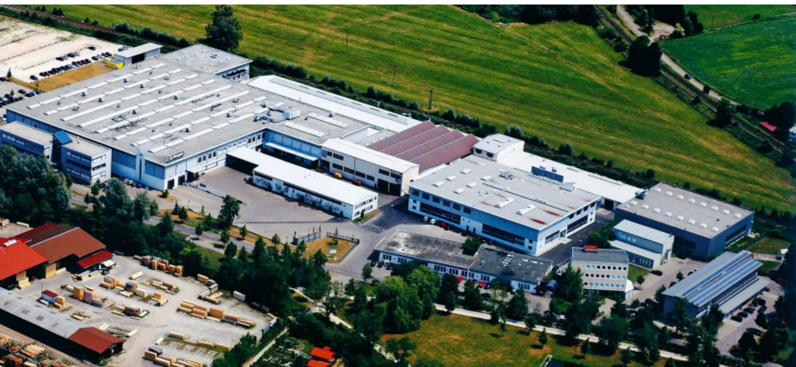
Luftaufnahme 2006 Standort Memmingen.
