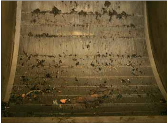
Un tamis sort les objets solides des liquides usés.
