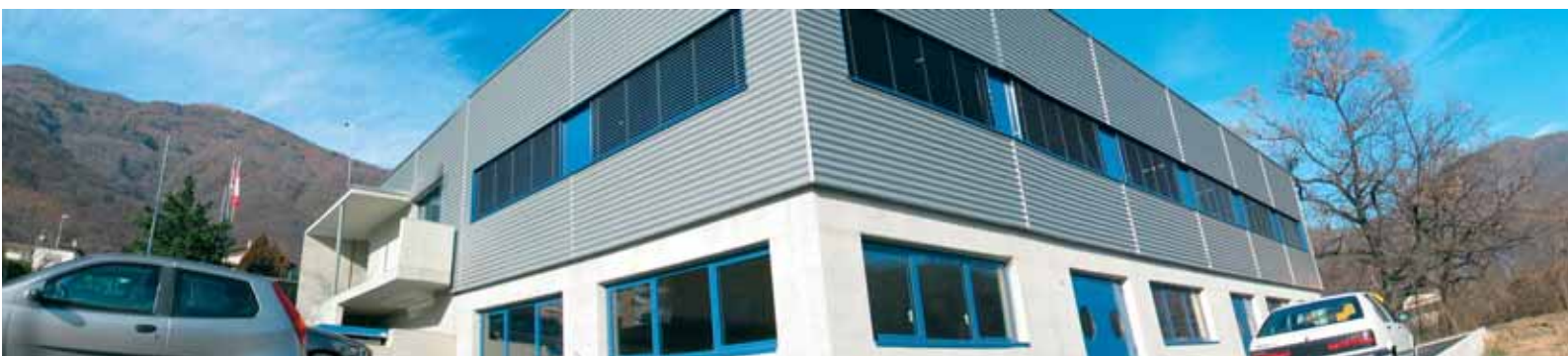
Komplett neuer Produktionsbetrieb für TS Décolletage als Zeichen der Dynamik des Erfolges des Unternehmens.
