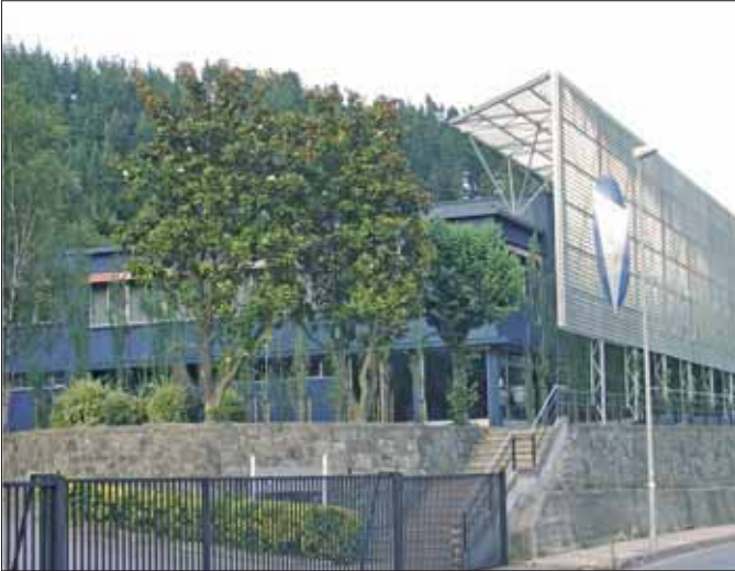
Die Fassade von Microdeco ermöglichte die harmonische Verbindung verschiedener Gebäude. Von aussen gesehen: eine technische Umgebung im Grünen.
