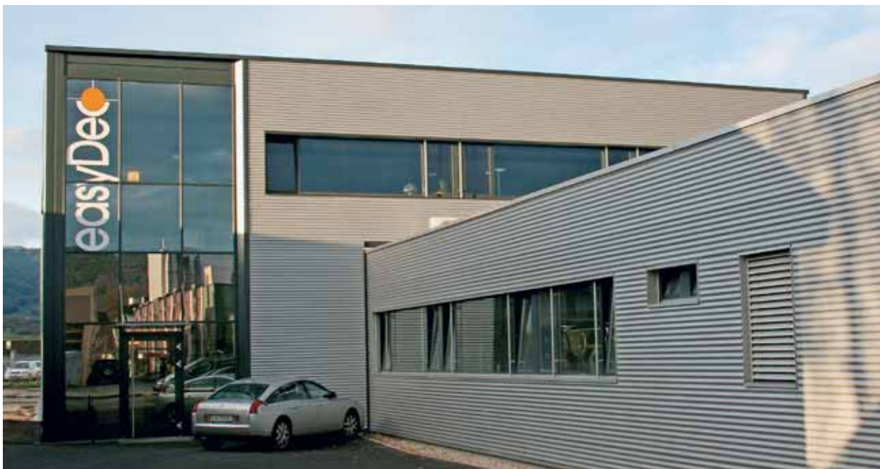
No prédio recém construído e supermoderno em Delémont, as máquinas operam 24 horas em dois andares.
