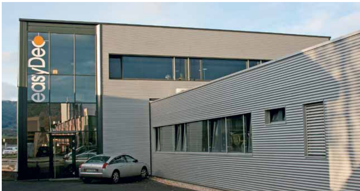
En el edificio recientemente inaugurado y supermoderno de dos plantas de Delémont trabajan las máquinas las 24 horas del día.
