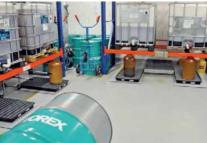
No tanque de alimentação de óleo, são estocados não apenas os lubrificantes, mas também os cavacos liberados e os fluidos de usinagem filtrados.
