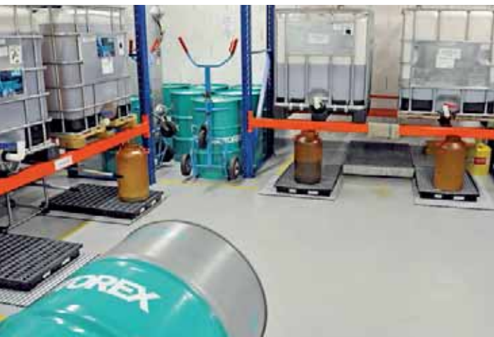
Nella vasca di alimentazione in olio, sono immagazzinati non solo i lubrificanti, ma anche i trucioli evacuati e i fluidi di lavorazione filtrati.
