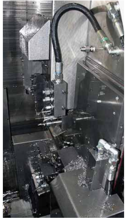
Sistema de tuberías de HPC fijado a platinas de herramientas.
